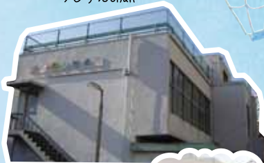
壁面と入口には 七色の文字で 「辻堂青少年会館」と 刻まれています。
