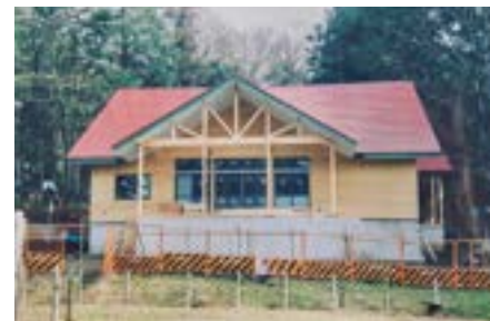
建設中のかわせみハウス
